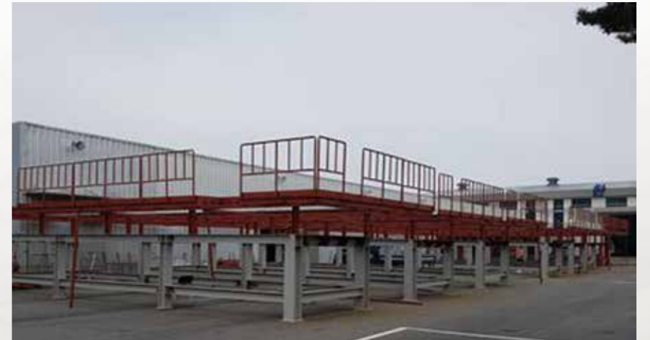
철구조물 제작 및 설치
