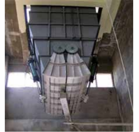
유압호퍼 제작 및 설치
